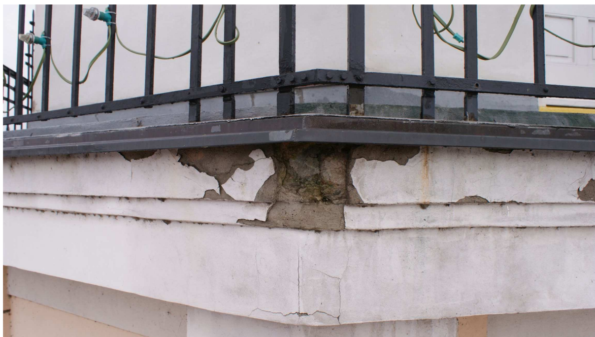
Pohled na bok ochozu radniční věže, patrné stopy po průsacích vody v okolí sloupků zábradlí.
