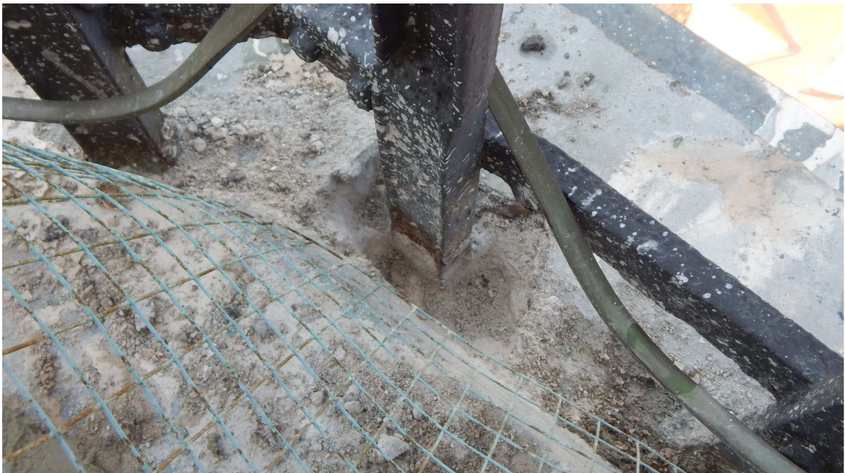
Pohled na sondu (bourací), patrný způsob uchycení sloupků zábradlí – zabetonování v nosné železobetonové konstrukci ochozu.
