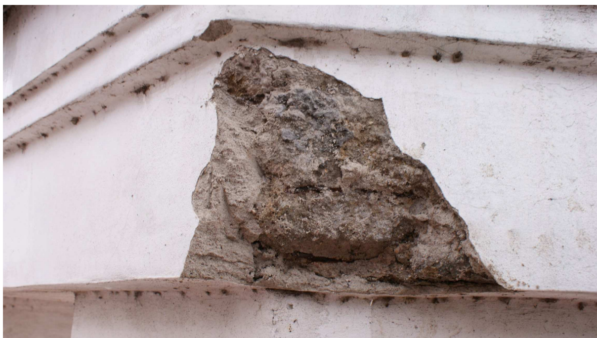
Održená a odpadá krycí vrstva betonu, povrchová koroze výztuže v místech průsaků, odpadávání omítky.
