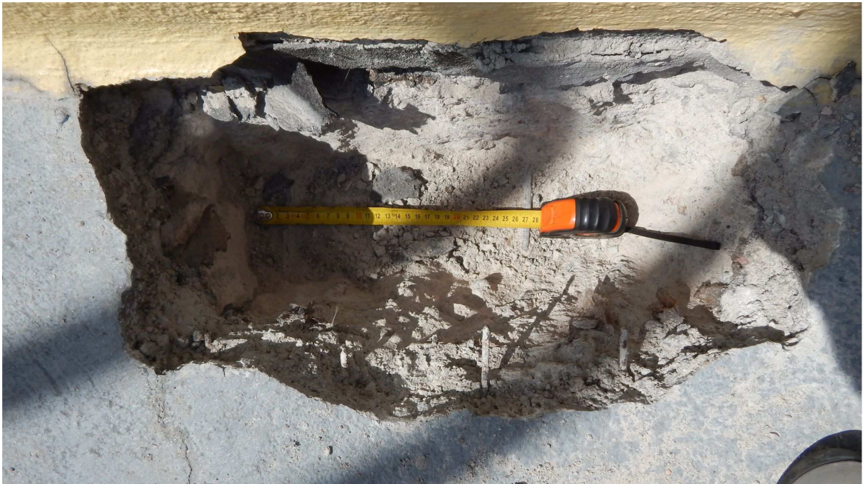
Pohled na sondu (bourací), patrné vyztužení pochozí betonové vrstvy pomocí sítě KARI, dále patrná výztuž nosné železobetonové konstrukce ochozu ( \varnothing 8/200 mm).
