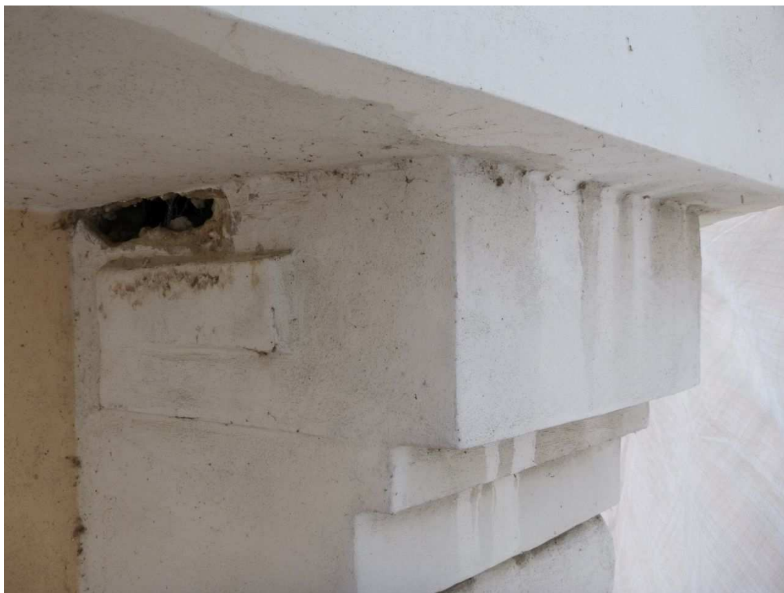
Ověřovací sonda v místě ozdobné konzoly pod ochozem, sondou ověřeno, že tato konzola neplní statickou, ale pouze dekorativní funkci.
